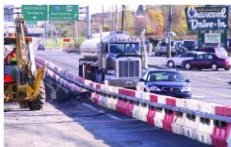
Longitudinal Barrier Wall
